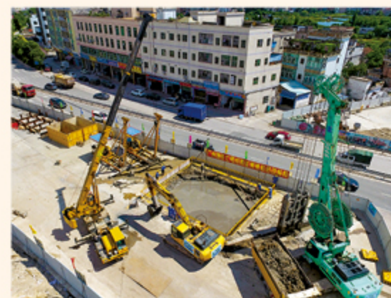
广州地铁7号线西延顺德段陈村站施工现场。
